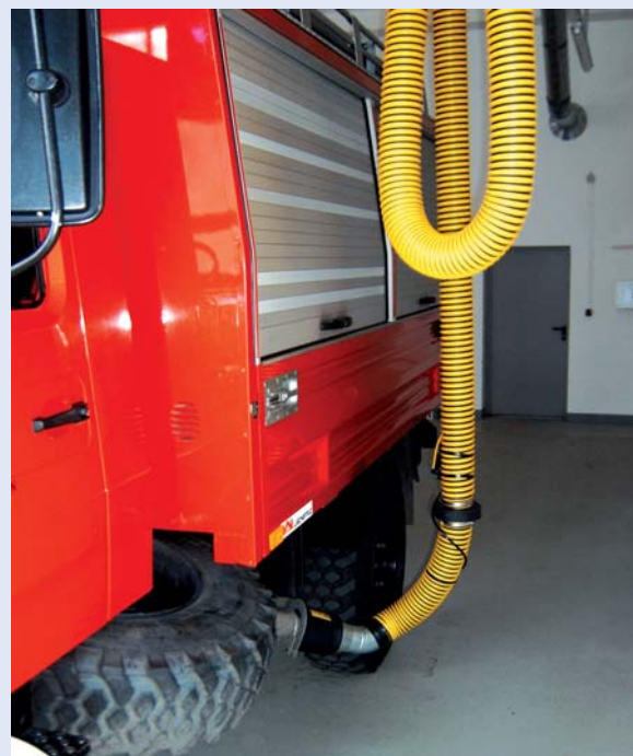
Abgasabsaugung an einem Feuerwehrfahrzeug.
