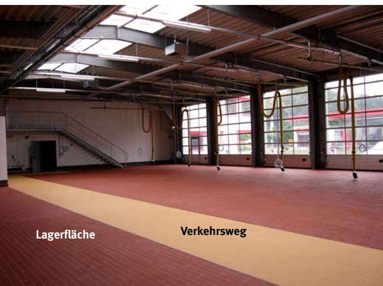
Bild 8 Farbliche Absetzung des Verkehrsweges in der Fahrzeughalle
