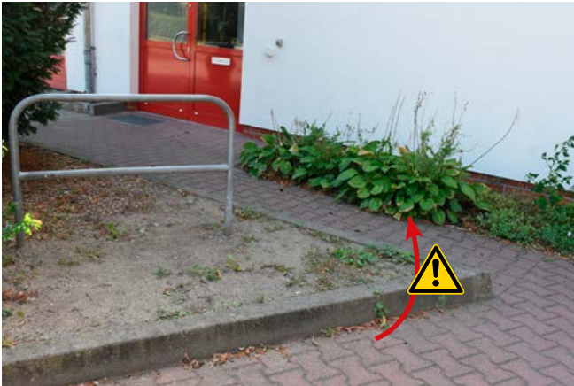
Bild 6 Hindernisse im Alarmweg
