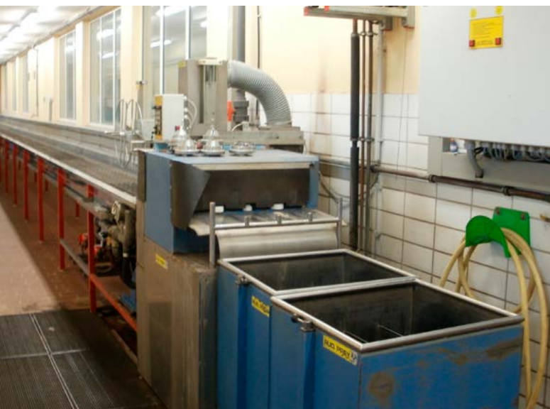
Bild 46 Fußboden mit Bodenablauf über begehbare Gitterrostfelder
