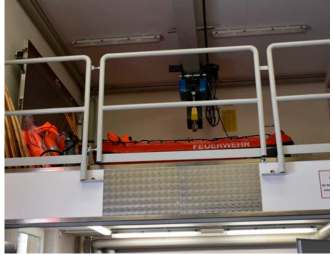
Bild 43 Zwischenboden (Fußleiste, Steckgeländer)
