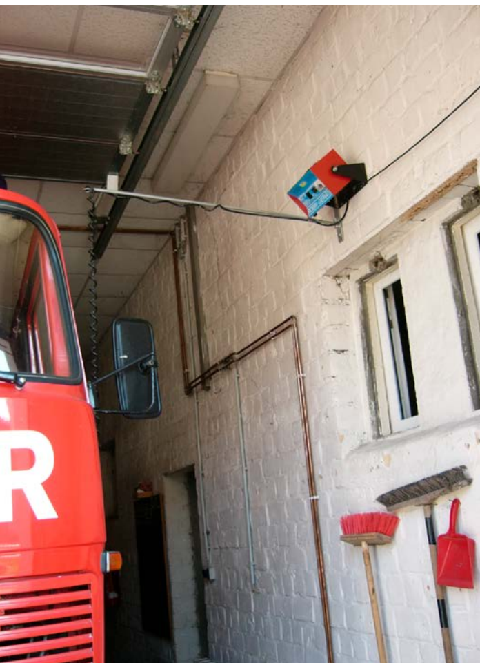
Bild 12 Über Galgen verlegtes Kabel
