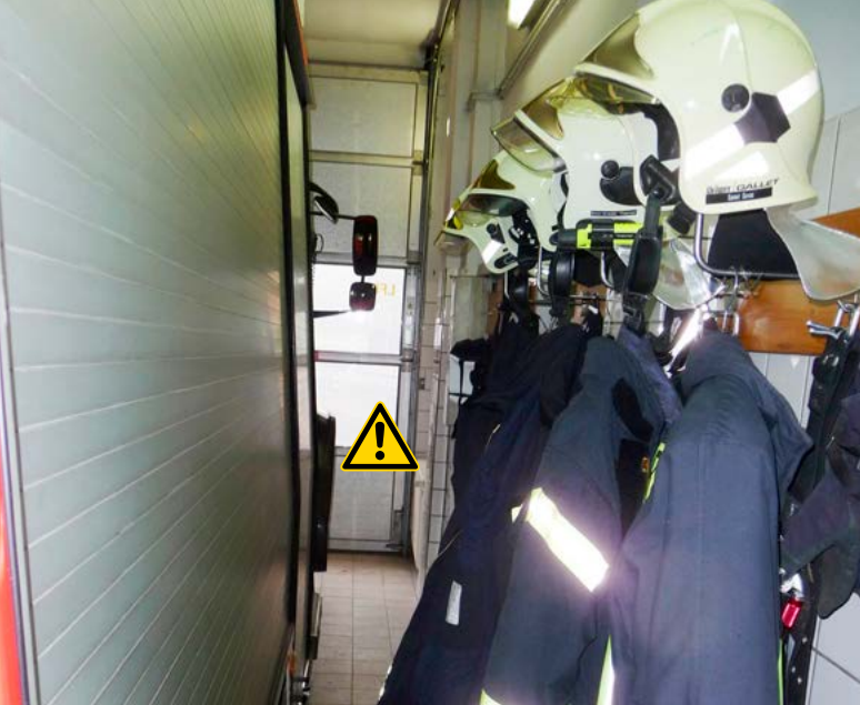
Bild 21 Zu geringe Abstände zwischen Haken für die Einsatzbekleidung und Feuerwehrfahrzeug
