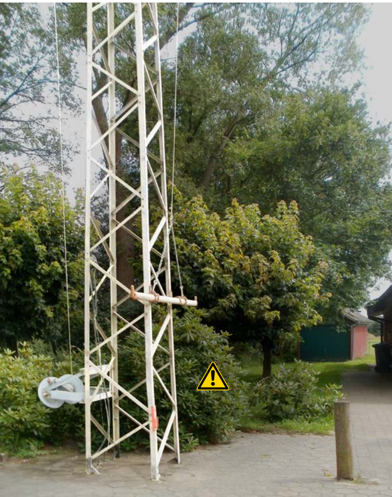
Bild 50 Ungesicherter Schlauchmast neben dem Feuerwehrhaus
