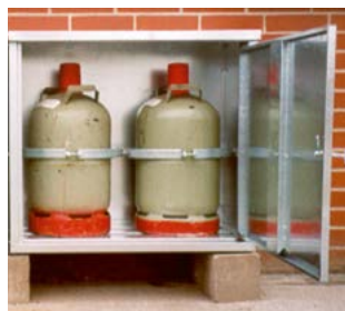
Bild 44 Kleinlager für Flüssiggasflaschen im Freien
