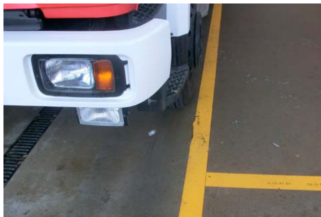
Bild 22 Kennzeichnung des Stellplatzes auf dem Hallenboden
