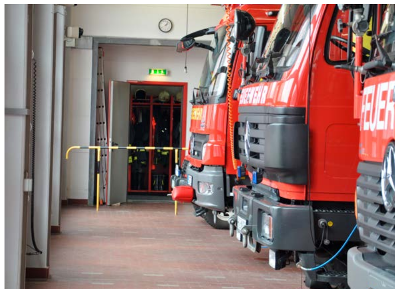
Bild 7 Geländer im Zugang zur Fahrzeughalle
